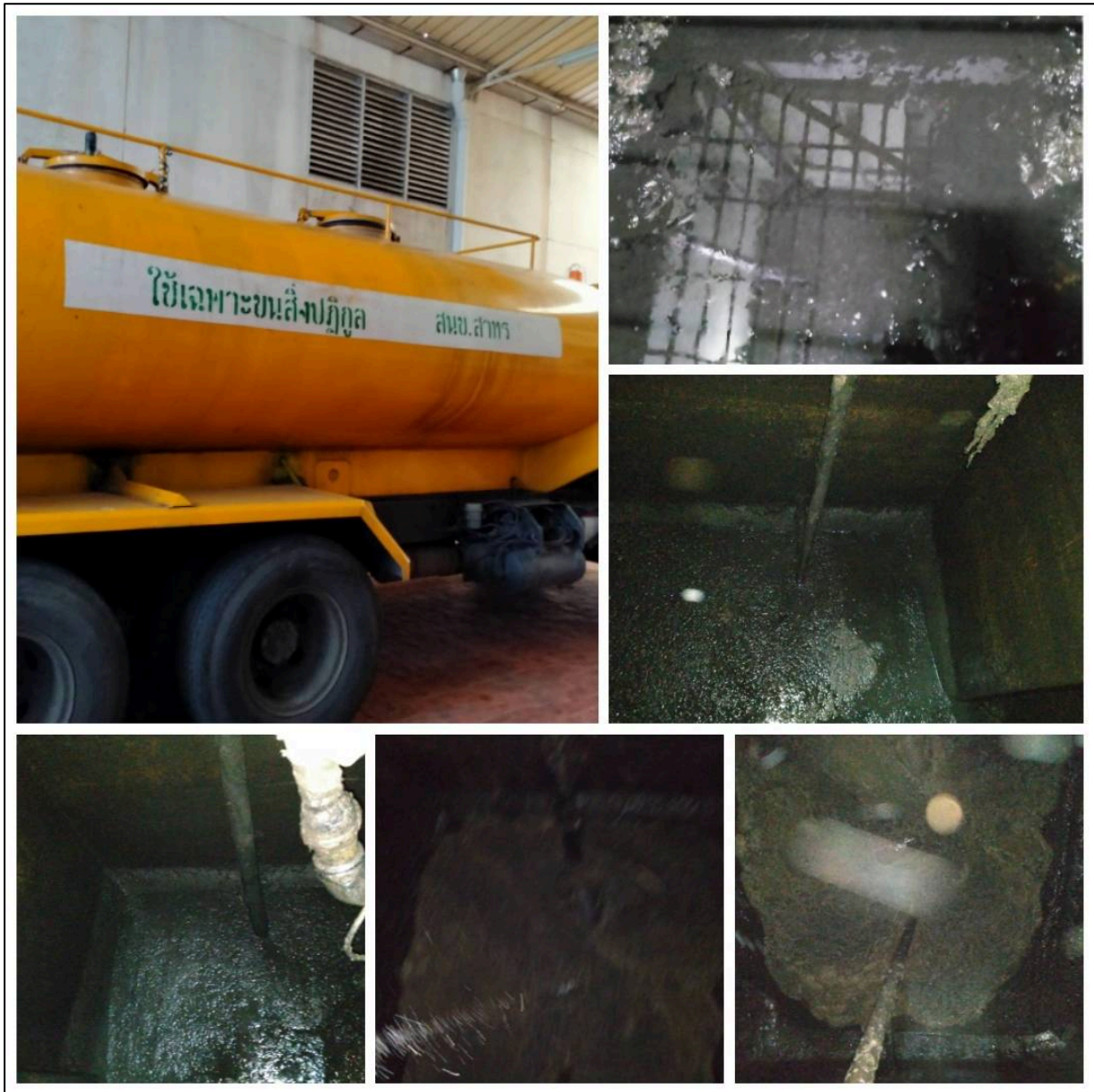
รูปที่ 20 (ต่อ) การขุดลอกที่ระบายน้ำ และสูบน้ำก่อนบำบัด โดยรอบโครงการ
