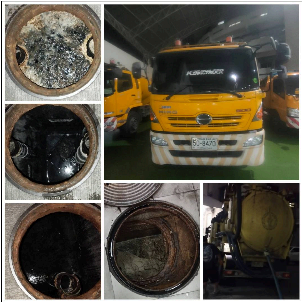
รูปที่ 20 (ต่อ) การขุดลอกท่อระบายน้ำ และสูบน้ำคอนกรีตบด โดยรอบโครงการ
