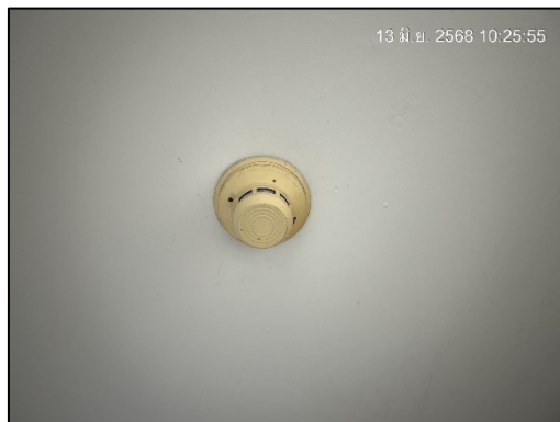
รูปที่ 44 (ต่อ) อุปกรณ์แจ้งเหตุเตือนเพลิงไหม้
