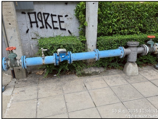
รูปที่ 25 มิเตอร์น้ำของโครงการ
