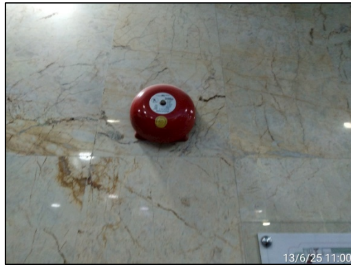
รูปที่ 44 (ต่อ) อุปกรณ์แจ้งเหตุเตือนเพลิงไหม้
