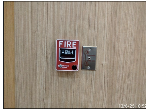
รูปที่ 44 (ต่อ) อุปกรณ์แจ้งเหตุเตือนเพลิงไหม้
