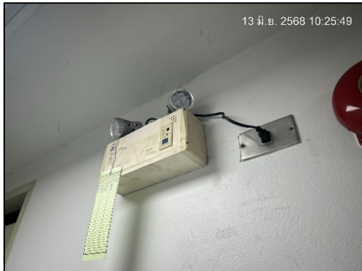
รูปที่ 50 (ต่อ) ไฟฉุกเฉิน ระบบไฟสำรองฉุกเฉิน
