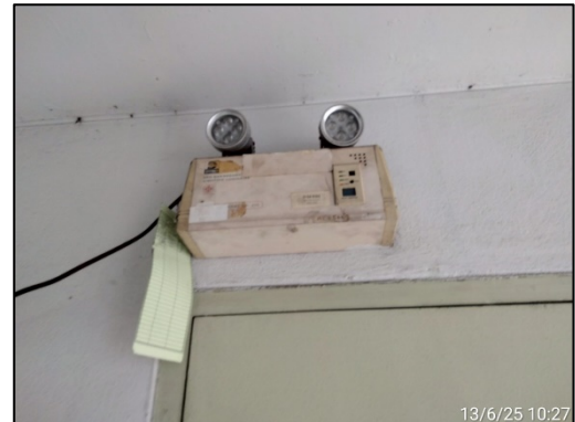
รูปที่ 50 (ต่อ) ไฟฉุกเฉิน ระบบไฟสำรองฉุกเฉิน
