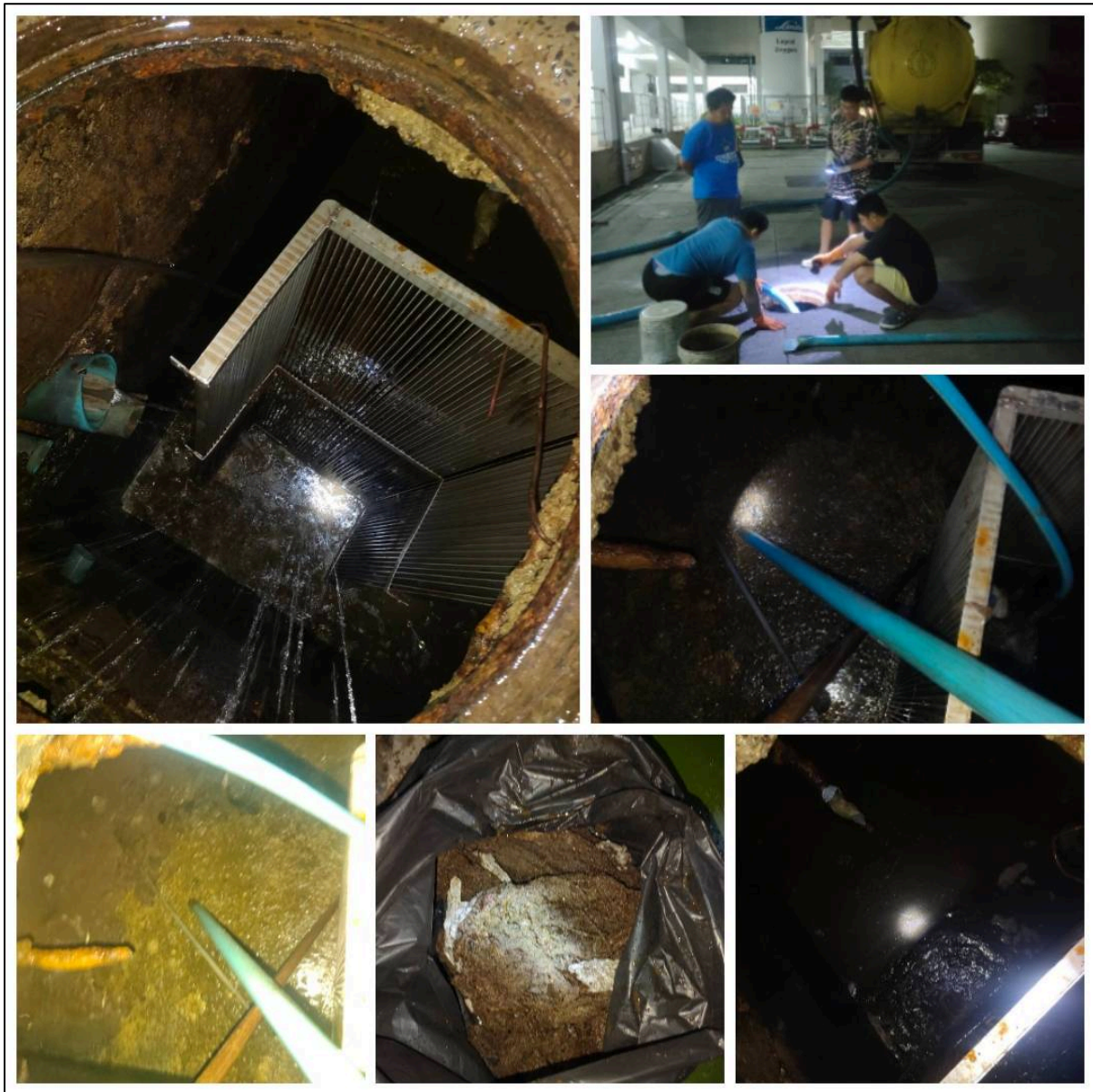
รูปที่ 39 (ต่อ) การสูบน้ำมันจากบ่อดักไขมัน
